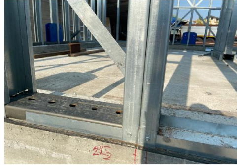
e) LFRS track-to-stud connection
