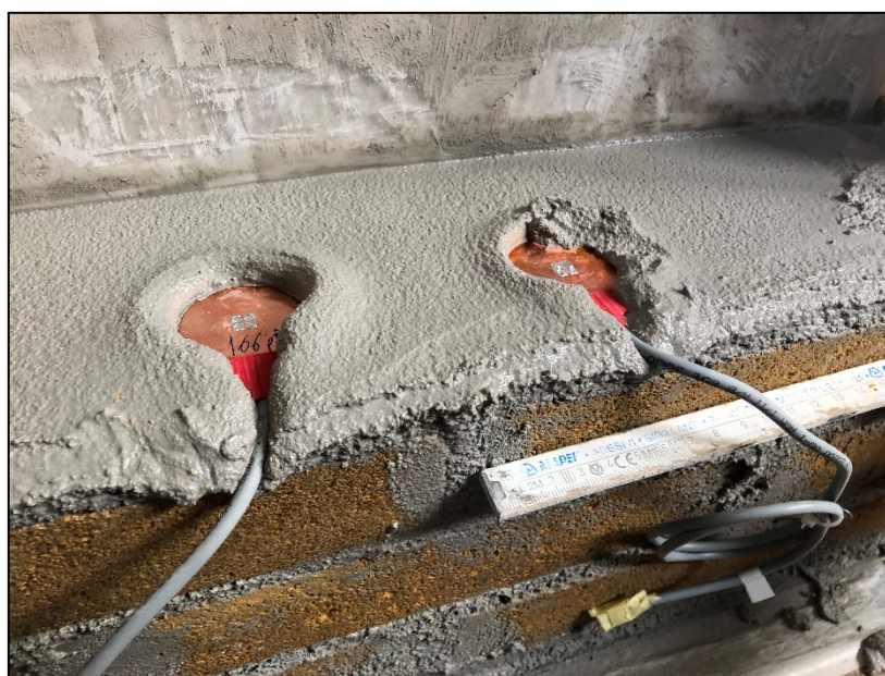
Figura 7.2.16 Sistema di pre-installazione sensoristica STMicroelectronics in strutture in muratura: realizzazione canaletta protezione cavo sensori all'esterno dell'armatura.
