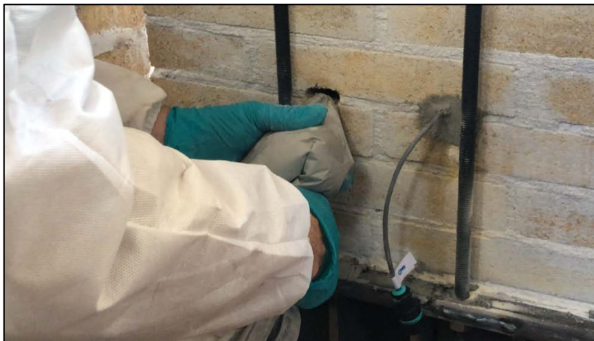
Figura 7.2.3 Primo sistema di post-installazione sensoristica STMicroelectronics: iniezione della boiaccia cementizia.
