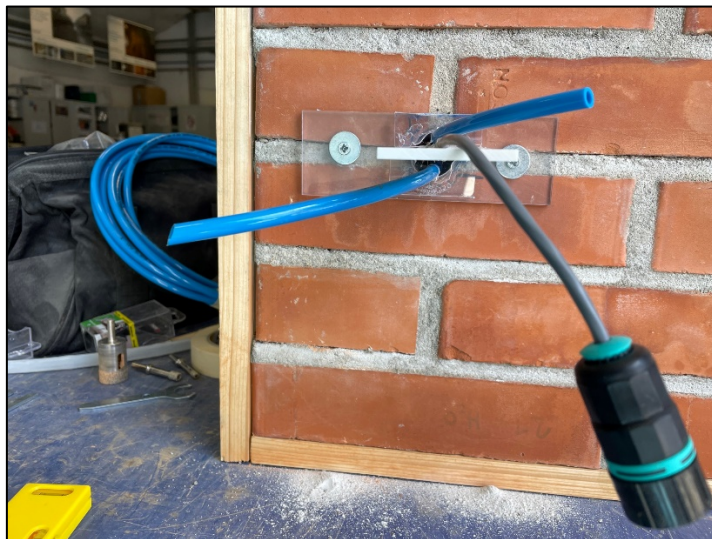
Figura 7.2.8 Secondo sistema di post-installazione sensoristica STMicroelectronics: posizionamento tubicini per l'iniezione della boiaccia.
