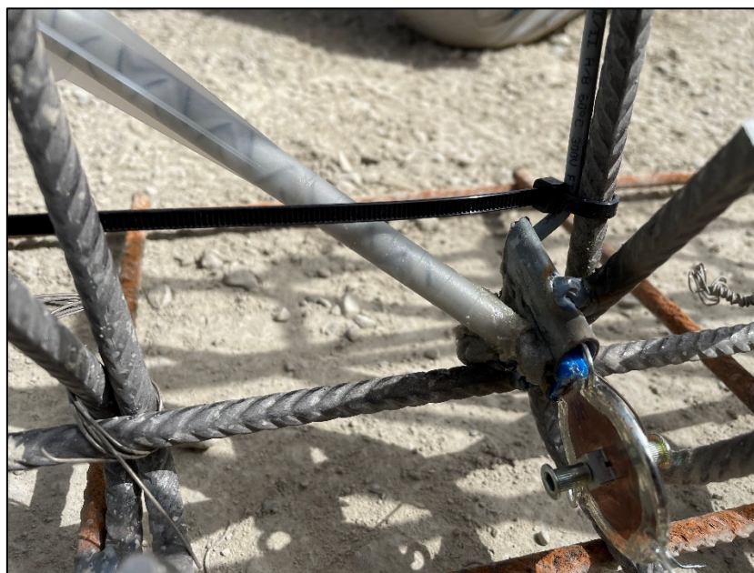
Figura 7.2.14 Sistema di pre-installazione sensoristica STMicroelectronics in elementi di calcestruzzo: sigillatura del cavo dei sensori.
