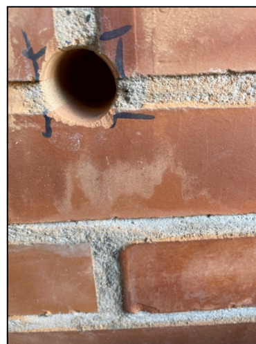
Figura 7.2.4 Secondo sistema di post-installazione sensoristica STMicroelectronics: carotaggio.
