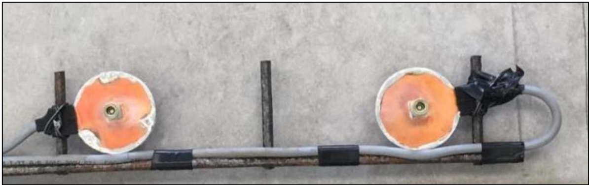
Figura 7.2.10 Terzo sistema di post-installazione sensoristica STMicroelectronics: fissaggio sensori su supporto metallico.
