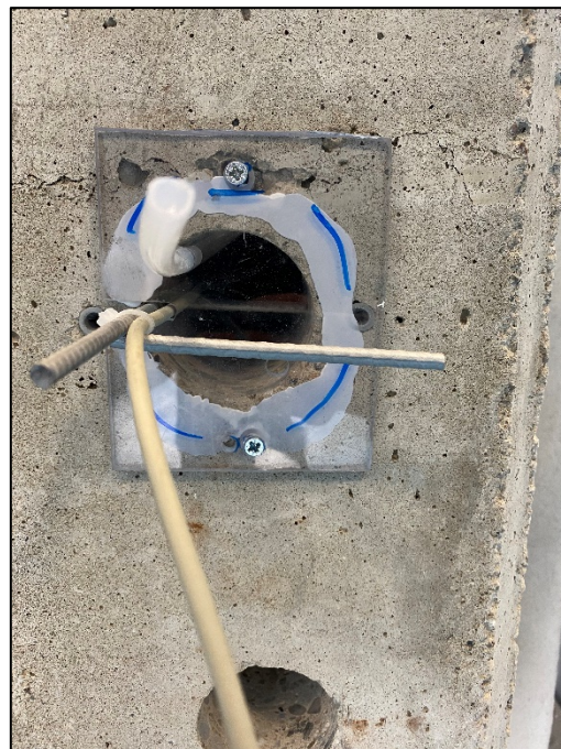
Figura 7.2.11 Terzo sistema di post-installazione sensoristica STMicroelectronics: fissaggio sensori su supporto metallico.
