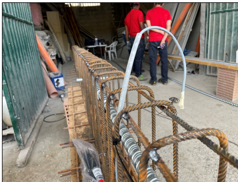
Figura 7.2.15 Sistema di pre-installazione sensoristica STMicroelectronics in elementi di calcestruzzo: realizzazione canaletta protezione cavo sensori all'esterno dell'armatura.
