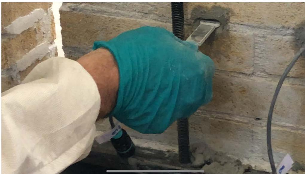
*Figura 4-8. Posizionamento sensori all'interno dei fori*
