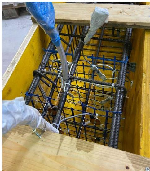
Figura 4-65. Fissaggio dei cavi
