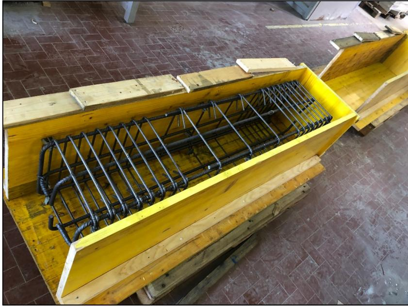
Figura 4-69. Predisposizione delle cassature e della gabbia di armatura
