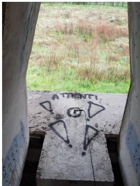
Figura 2-13. Posizione accelerometro orizzontale longitudinale sul dente di arresto presente sulla testa della pila
