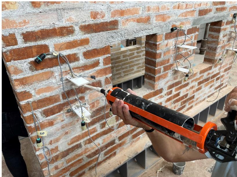
Figura 4-13. Iniezione di boiaccia con sistemi di tubicini con sistema di fuoriuscita di aria
