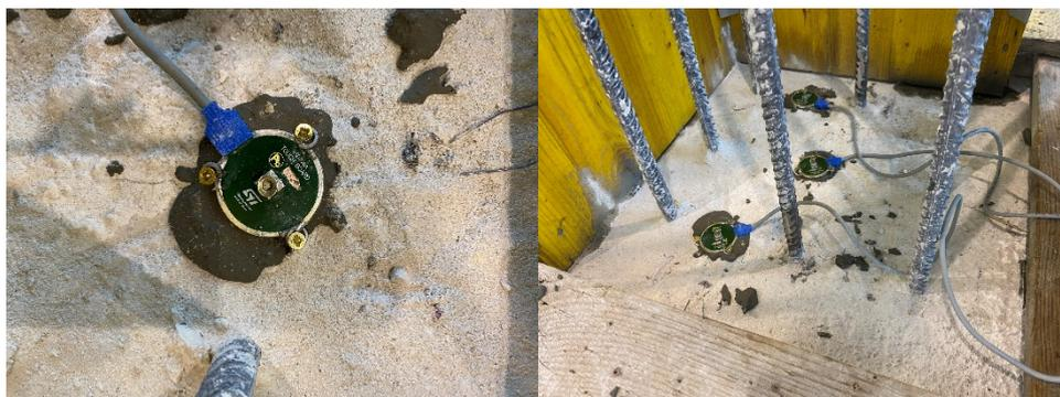
*Figura 4-53. Installazione sensori alla base dei pilastri*
