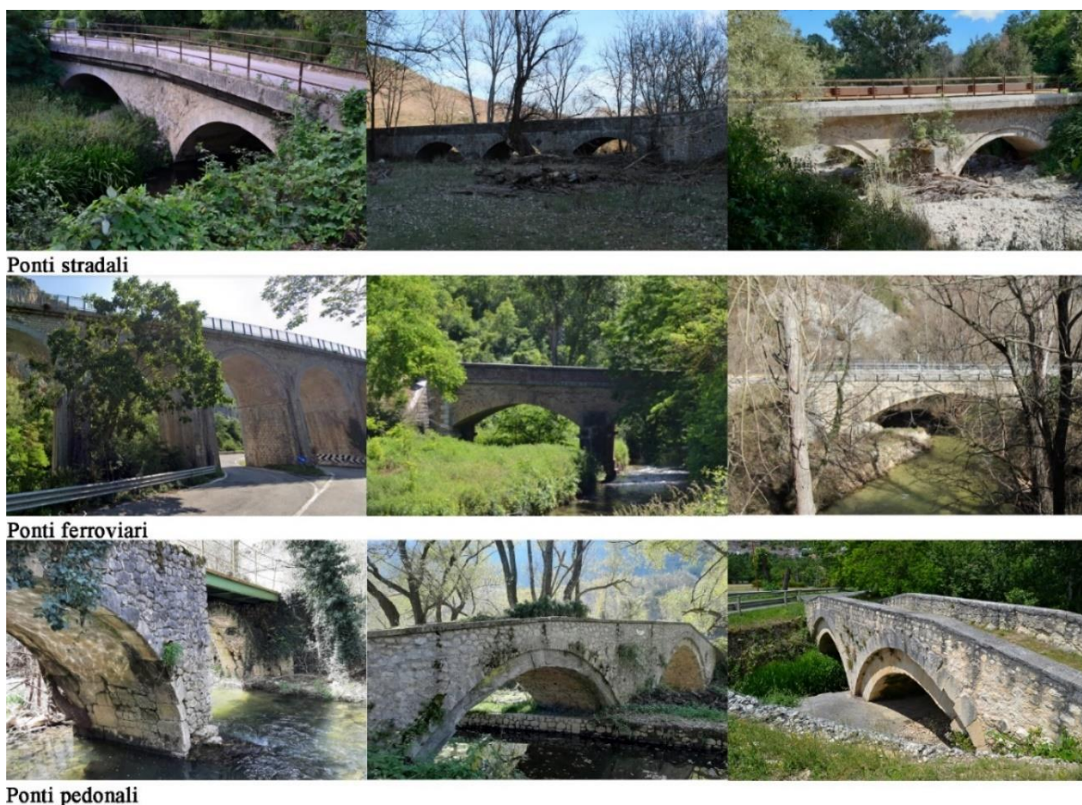
Figura 72 – Alcuni ponti storici ad arco in muratura che consentono l'attraversamento del fiume Aterno
