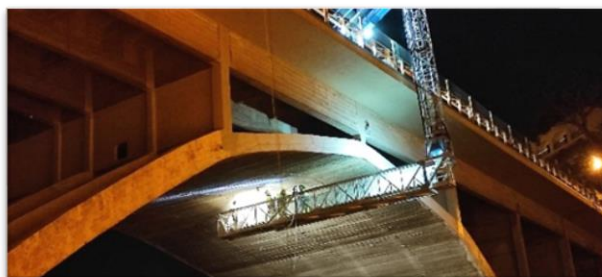
Installazione dei sensori e delle centraline effettuati in notturna
