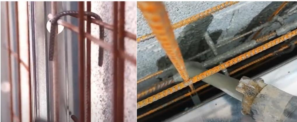
**Figura 10** Composizione stratigrafica della tecnologia e dettagli della tecnologia “Sisma Coat”
