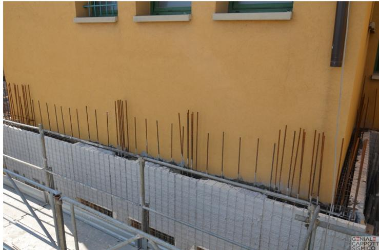
**Figura 6** Esempio di installazione della tecnologia “Geniale Cappotto Sismico”
