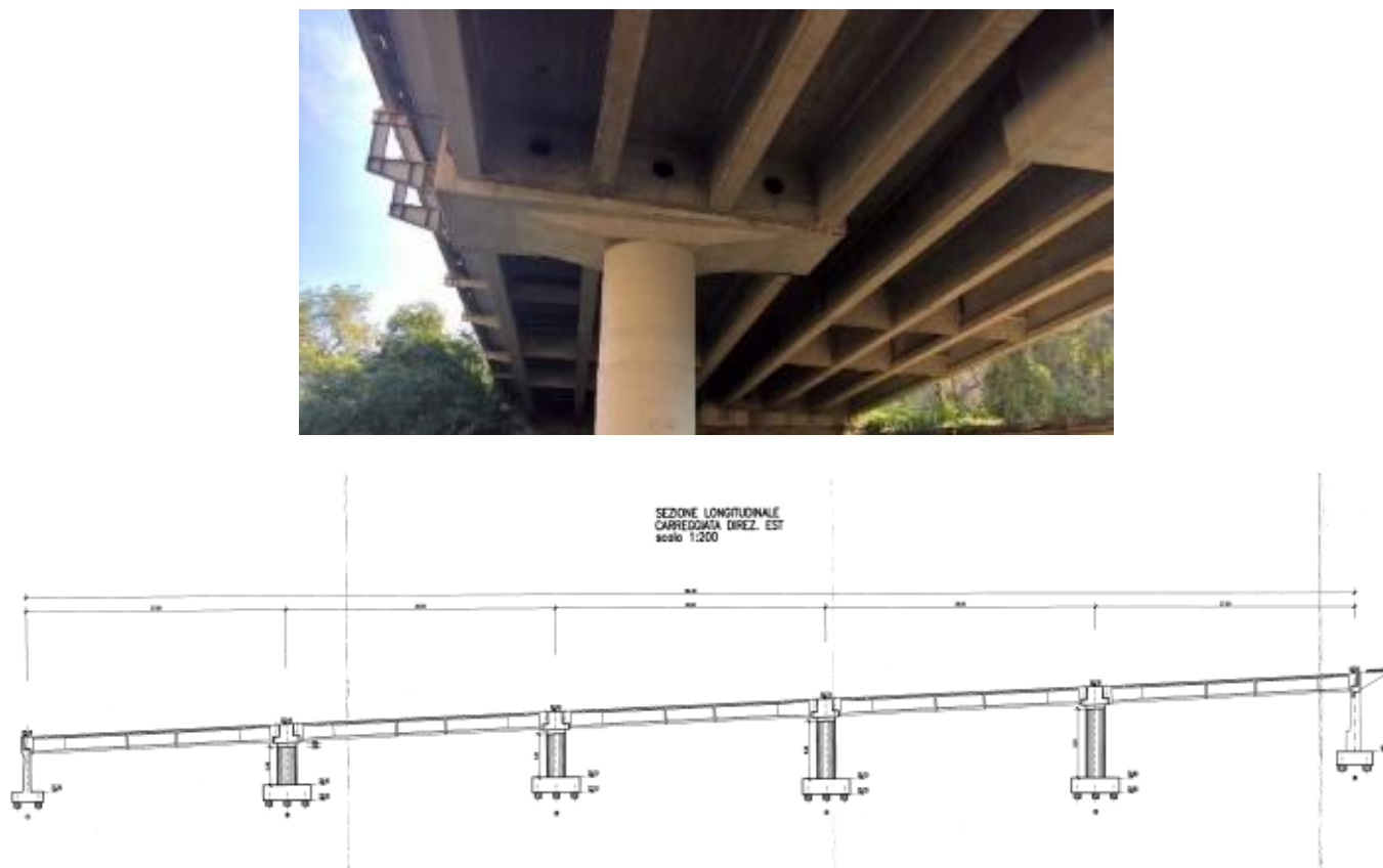
Figura 4.3. Vista complessiva del ponte. In alto, si presenta una vista inferiore dell'impalcato; in basso, una sezione longitudinale del ponte, estratta dalle tavole del progetto originale.
